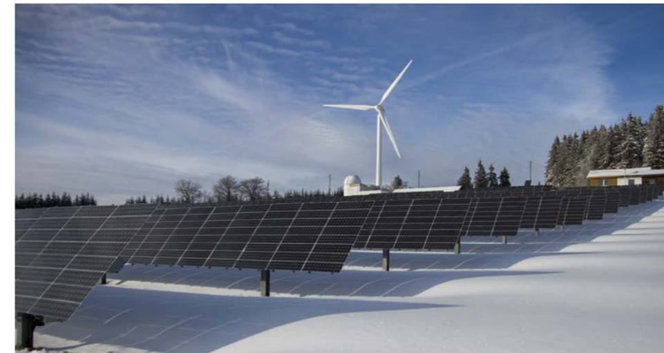
Photovoltaik-Anlage mit Windrad im Hintergrund
