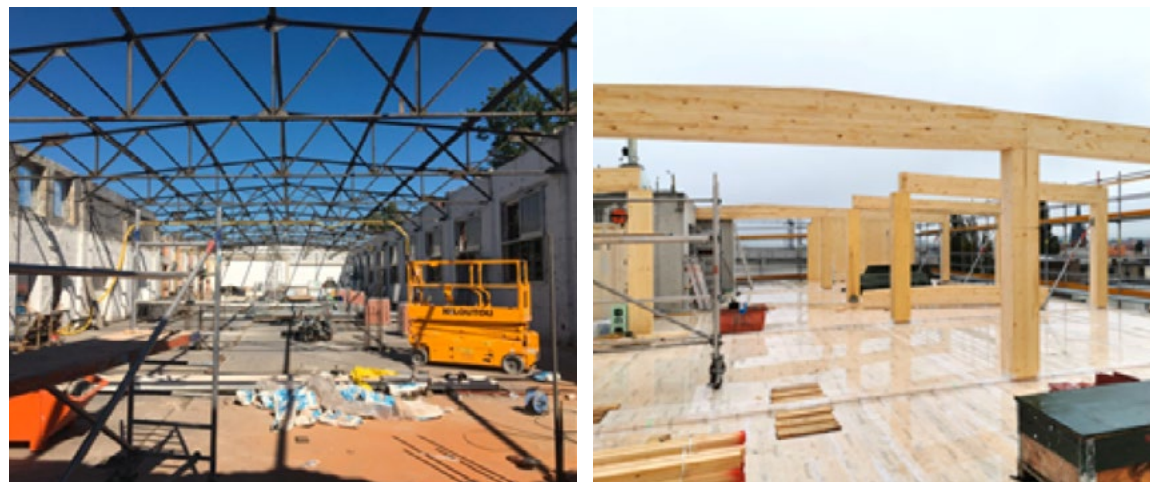
Obrázek 8: Renovace stávající budovy a přístavba v dřevěné konstrukci
