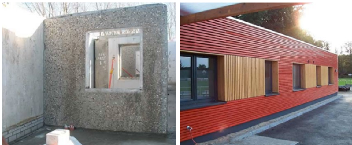
Obrázek 10: Sportovní dům Kolkwitz - opětovné použití železobetonových desek
