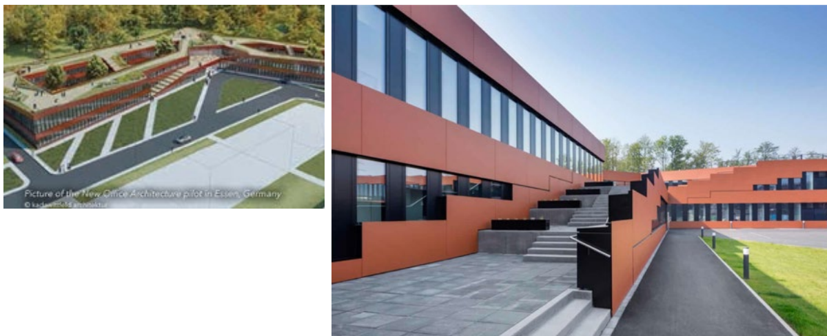
Obrázek 3: Nová kancelářská budova
