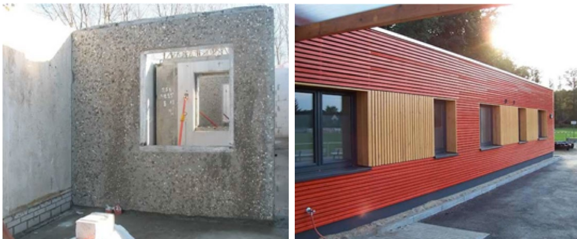
Slika 10: Sports House v Kolkwitzu – ponovno uporabljene in ojačane betonske plošče
