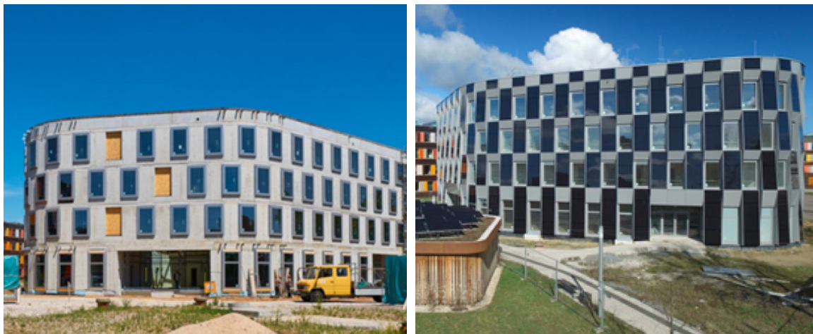
Slika 9: Stavba UBA – novogradnja z uporabo recikliranega betona
