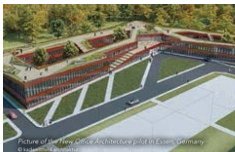
Slika 3: stavba „Nova pisarna“
