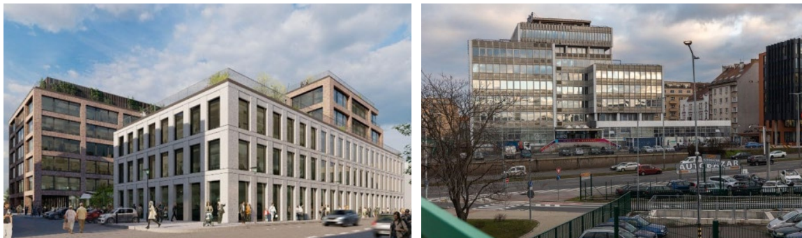
Slika 7: Poslovna stavba Mercury: nova in obstoječa stavba
