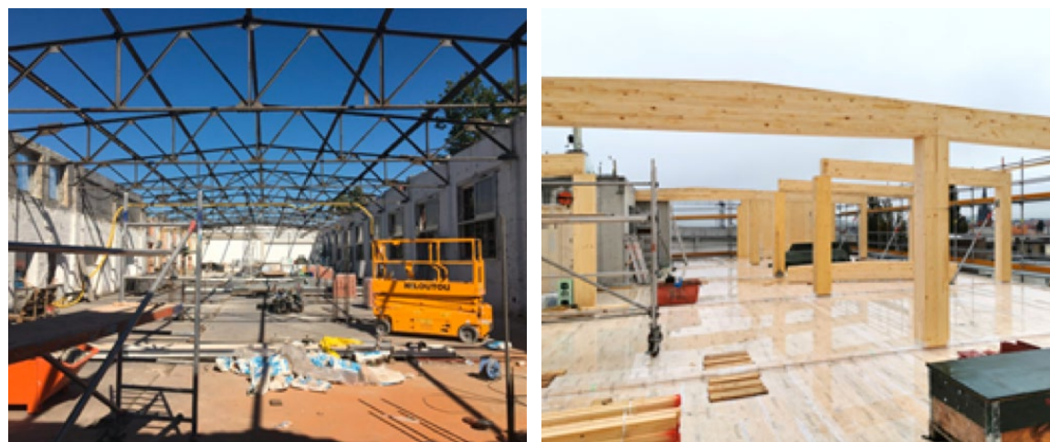
Slika 8: Obnova obstoječe stavbe in razširitev z leseno konstrukcijo
